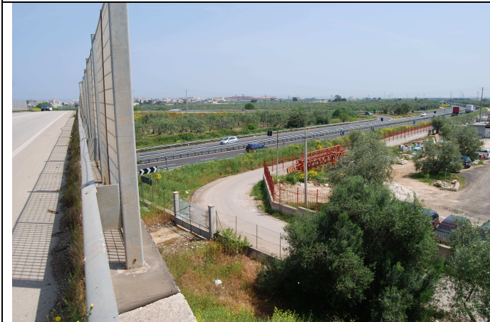
Indicazione dell'ostacolo determinato dalla SS16 rispetto al ramo in destra idraulica. Si nota come i due tubi posti sulla provinciale (ø800) siano ubicati in maniera non funzionale e i deflussi oltrepassano il cavalcavia verso sinistra passando al di sotto di esso. In blu sono indicati i vettori velocità la cui dimensione è proporzionale al valore di velocità massima registrato nel tempo in ogni cella.
