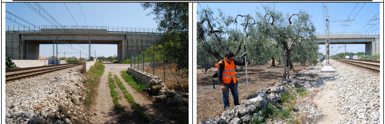
Sbarramento determinato dalla linea ferroviaria che, ad ogni modo, viene sormontata dai deflussi di piena sul lato destro rispetto al cavalcavia.
