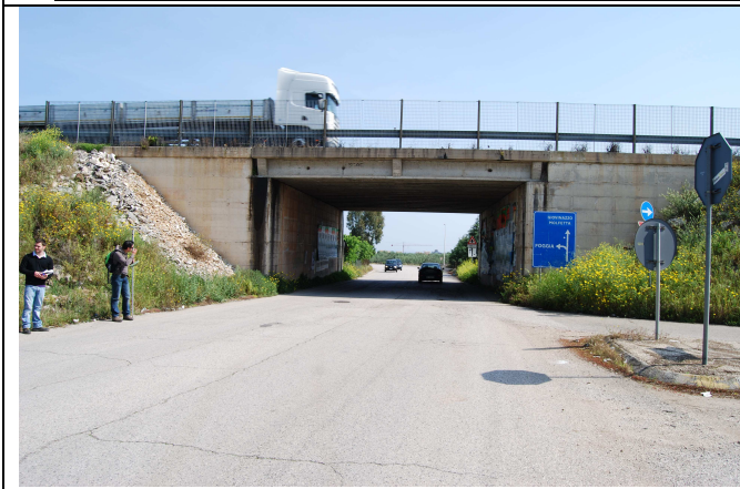
Sottopasso della strada comunale Colaolidda, attraverso il quale defluisce la piena. Nella seconda foto si nota come a destra le quote diventano più basse e quindi le acque tendano a defluire verso quella direzione
