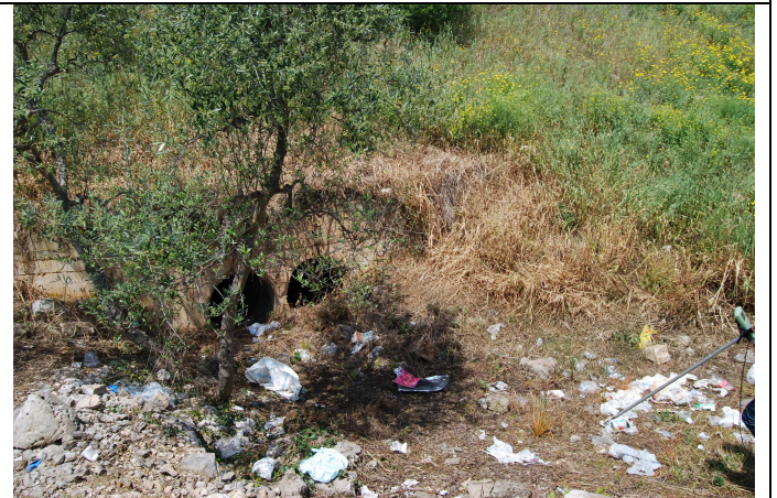
Indicazione dell'ostacolo determinato dalla SS16 rispetto al ramo in destra idraulica. Si nota come i due tubi posti sulla provinciale (ø800) siano ubicati in maniera non funzionale e i deflussi oltrepassano il cavalcavia verso sinistra passando al di sotto di esso. In blu sono indicati i vettori velocità la cui dimensione è proporzionale al valore di velocità massima registrato nel tempo in ogni cella.
