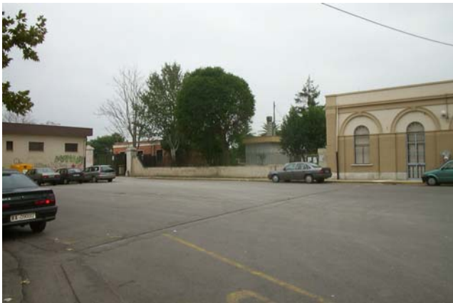
p.zza RISORGIMENTO Impianto n°104
