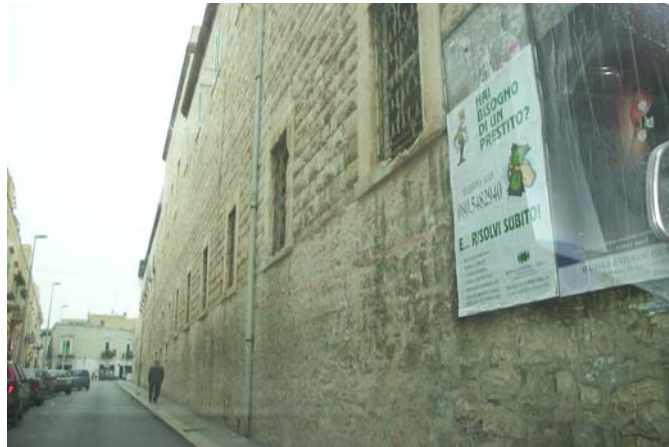
via MARCONI Impianto n°105
