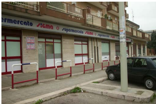
via don PISCITELLI Impianto n°62
