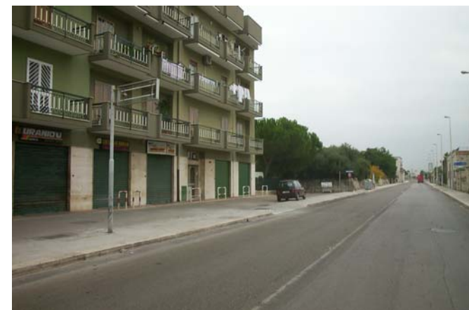
via BARI Impianti n°114 a n°115
