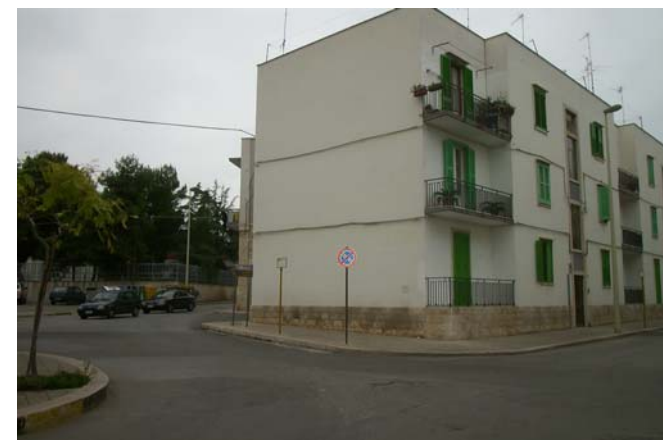
via Ten. DE VENUTO Impianto n°73
