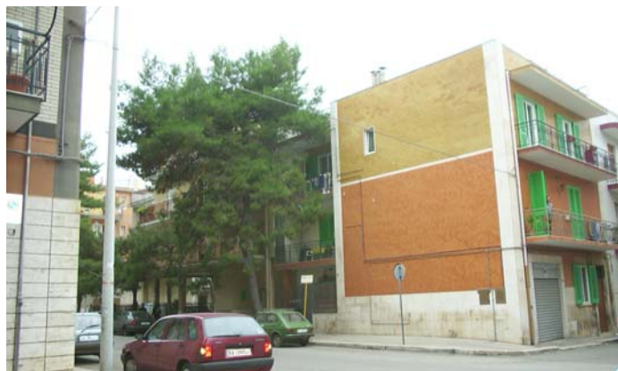
via DE GASPERI Impianto n°108
