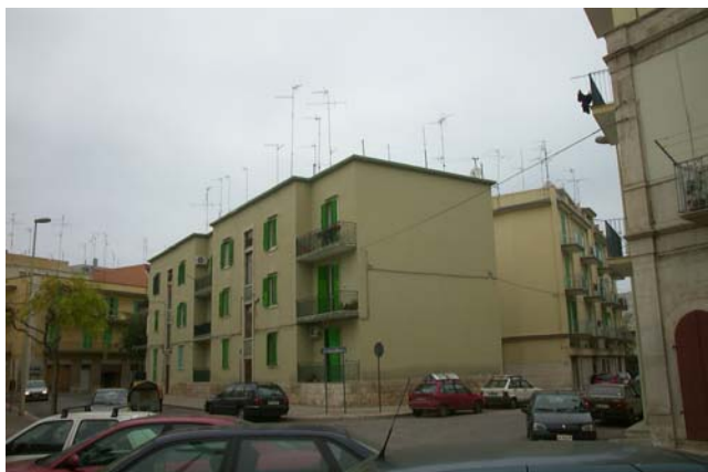
via VERNICE Impianto n°71
