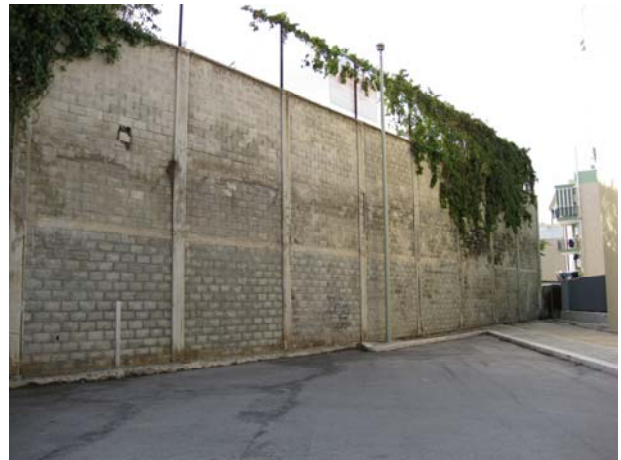
Vista esterna all'area di indagine
